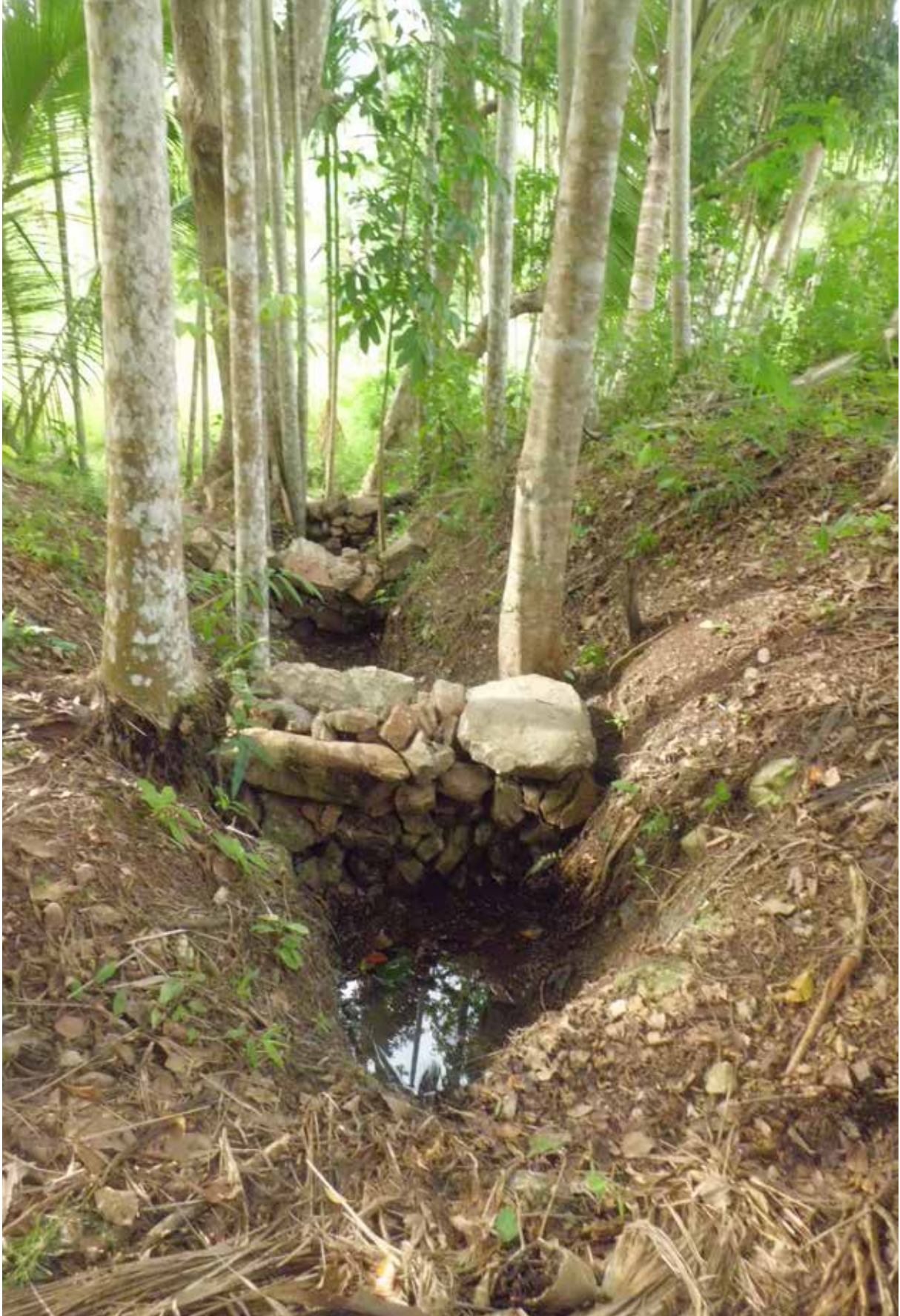
Jebakan air yang sudah berfungsi dan masih ada air yang tergenang pada saat musim kemarau.
