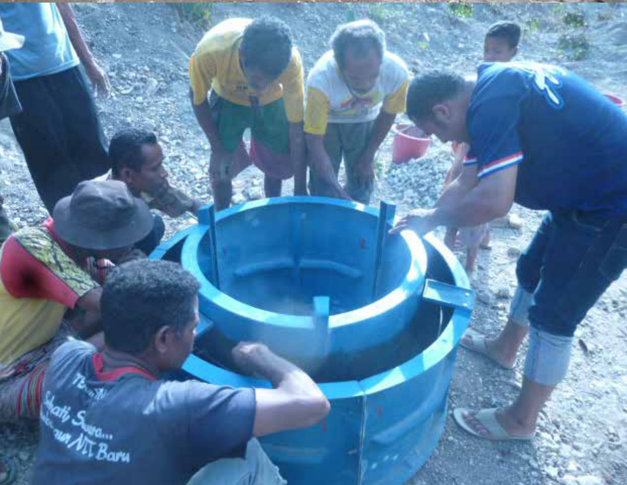
Penggalian awal sumur dan proses pembuatan cincin beton untuk dinding sumur.
