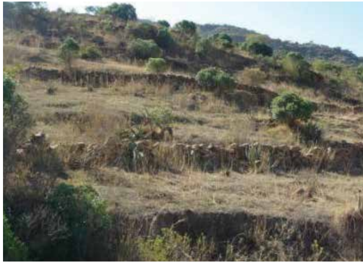
Contoh proses recharge : terasering batu di sisi bukit.
