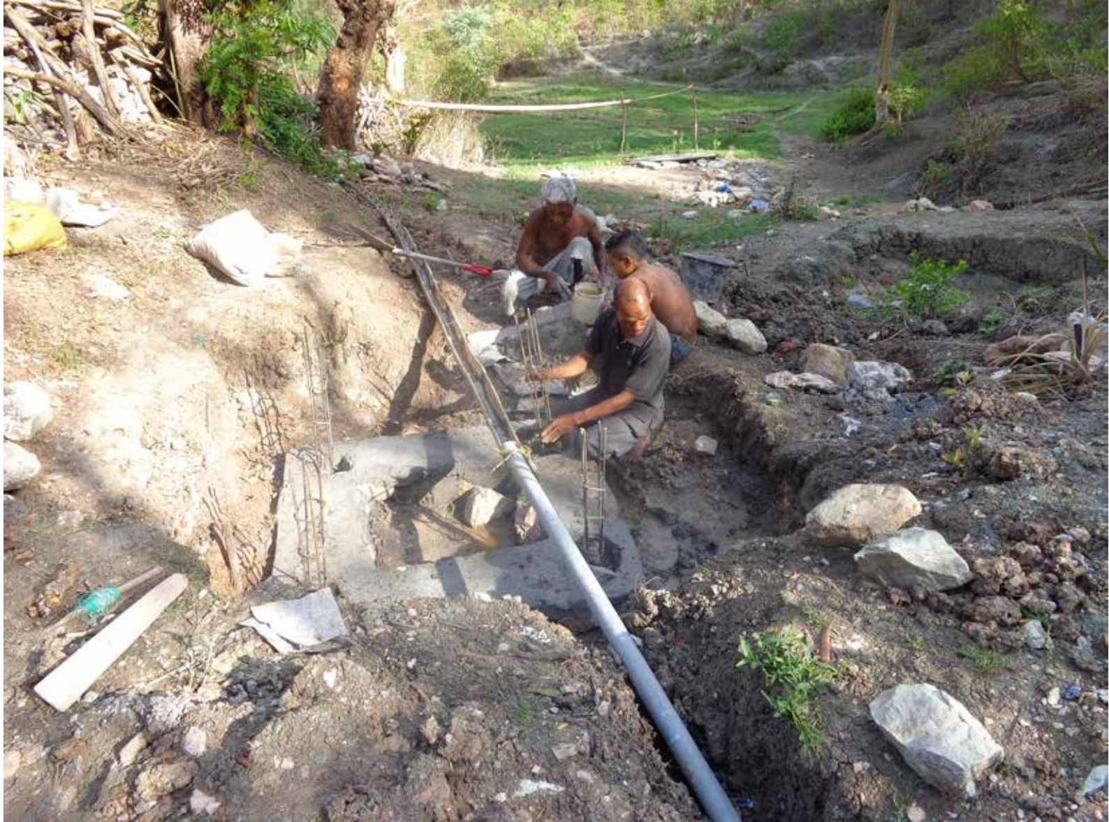
Proses pengerjaan PMA di mata air.
