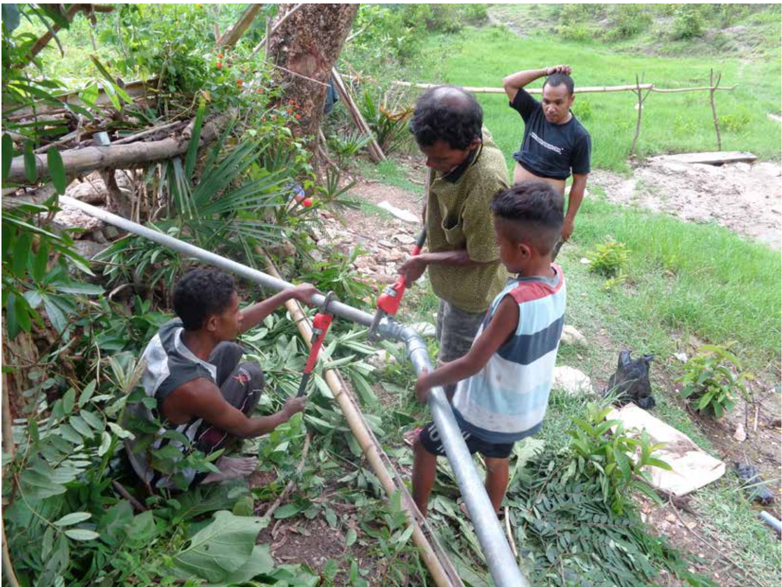
Proses pengerjaan PMA di mata air.
