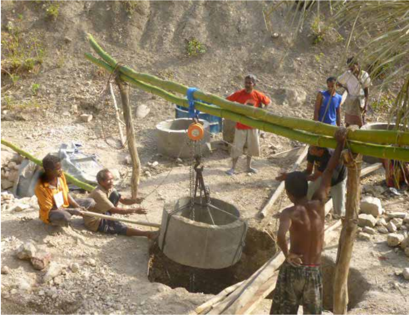
Proses pemasangan cincin.
