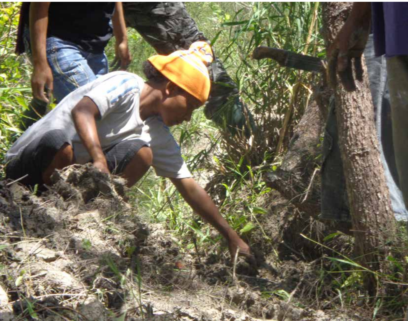
Proses pembuatan saluran air untuk mengurangi genangan yang terletak di Desa Baki.
