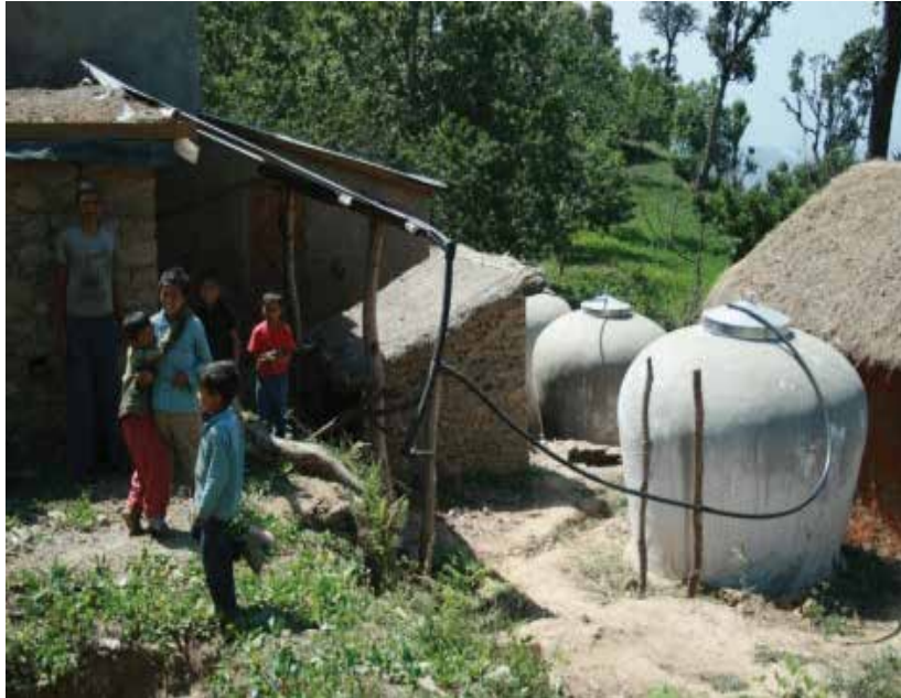
Contoh penyimpanan air: penampungan air hujan dari atap.
