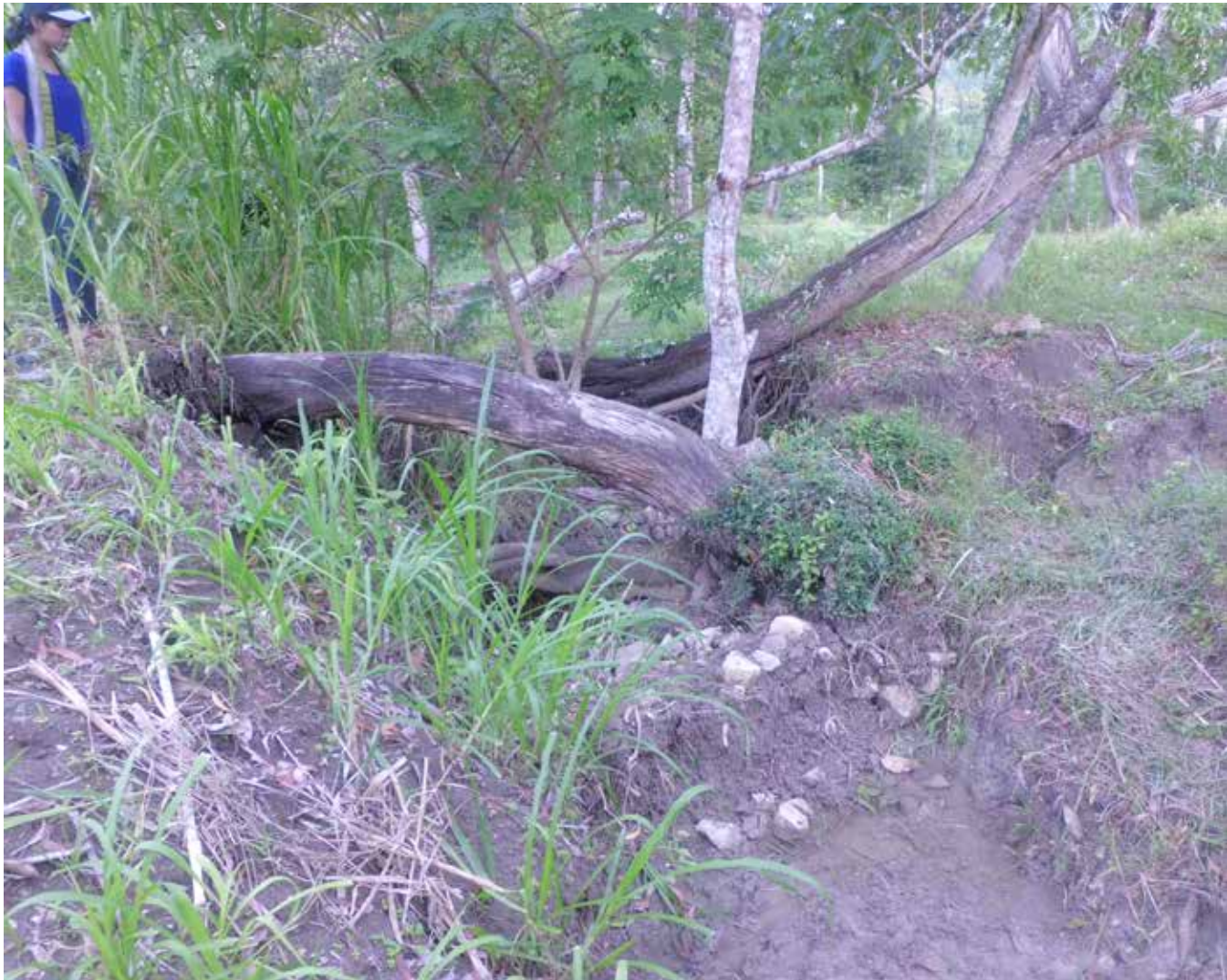
Jebakan air yang baru selesai dan siap difungsikan.
