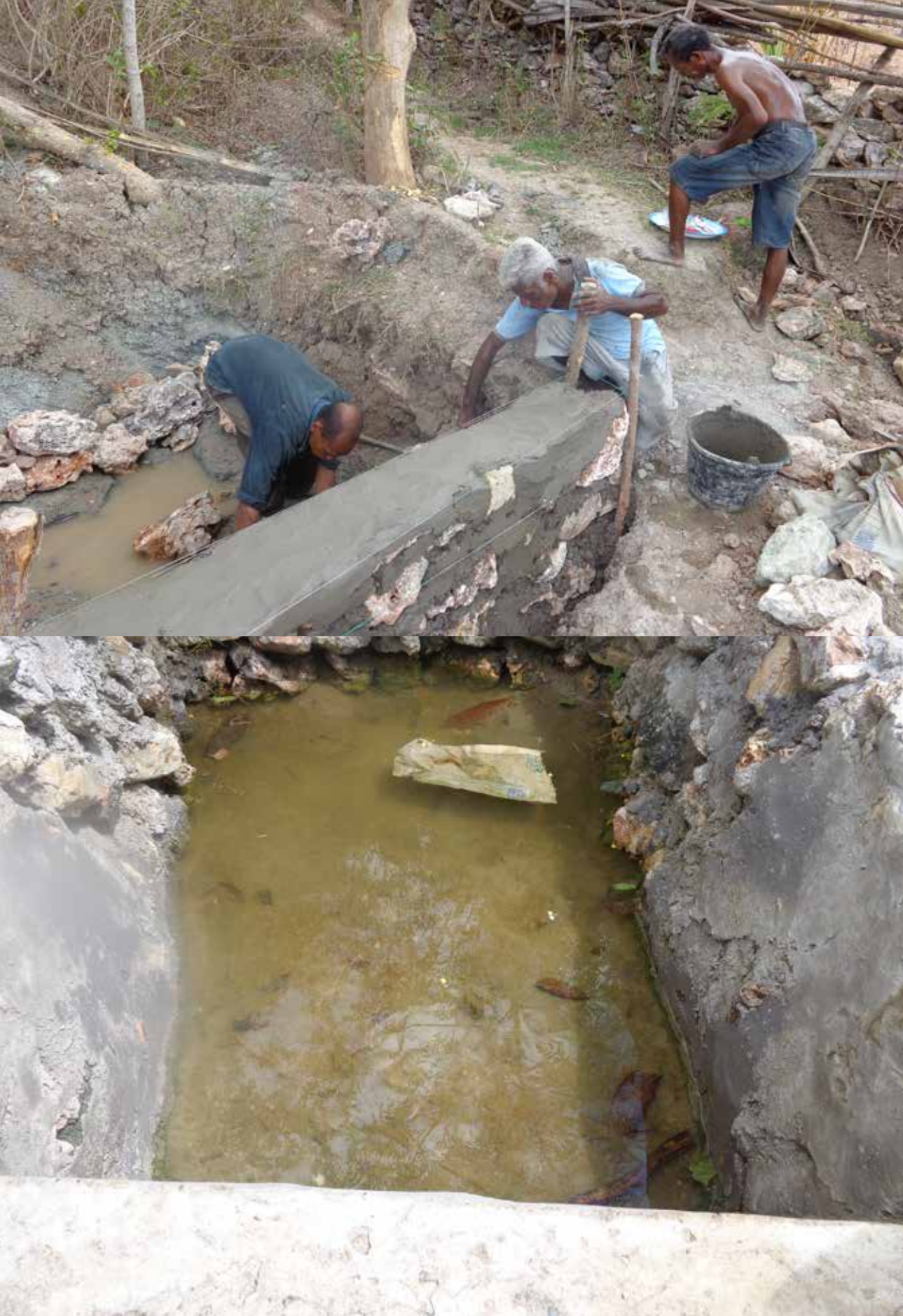
Proses pengerjaan PMA di mata air.
