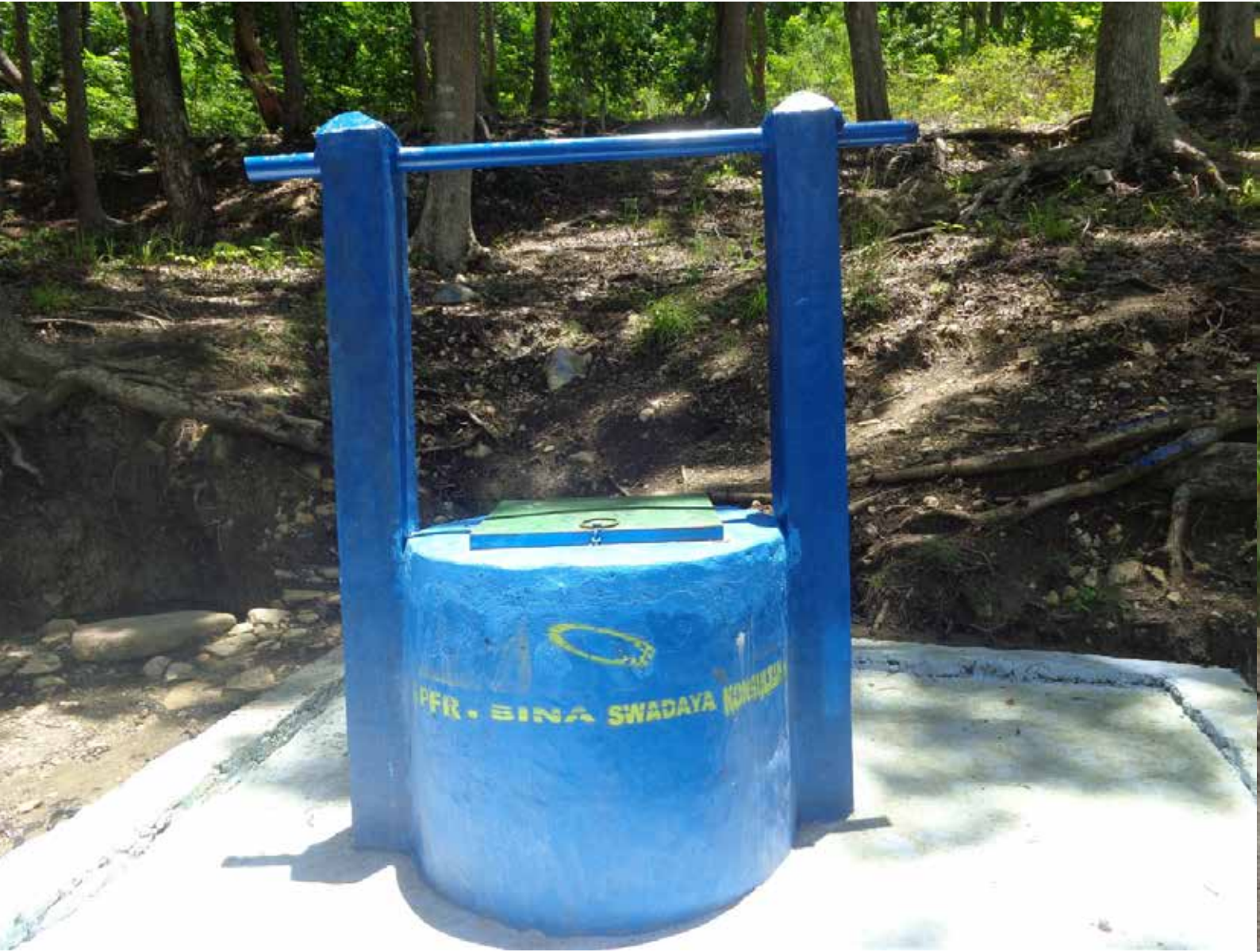
Sumur Oebak di (Rt 07 A Dusun III)
