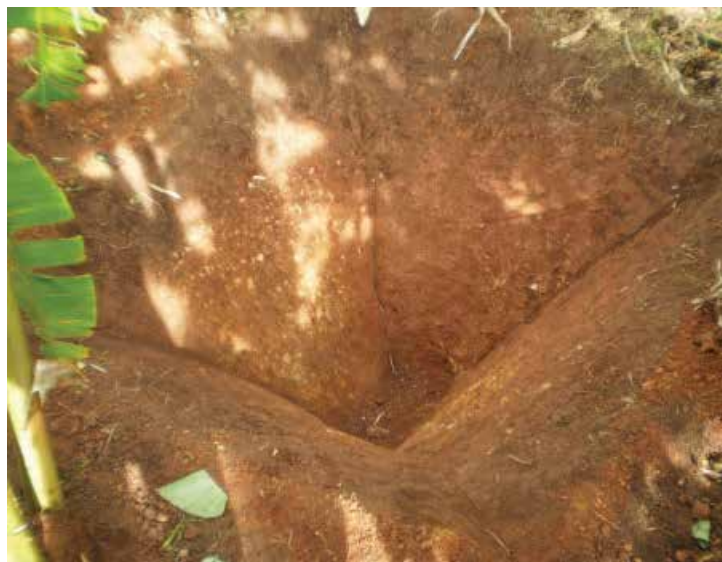
Contoh proses recharge : lubang penyaringan ( infiltration pit ).
