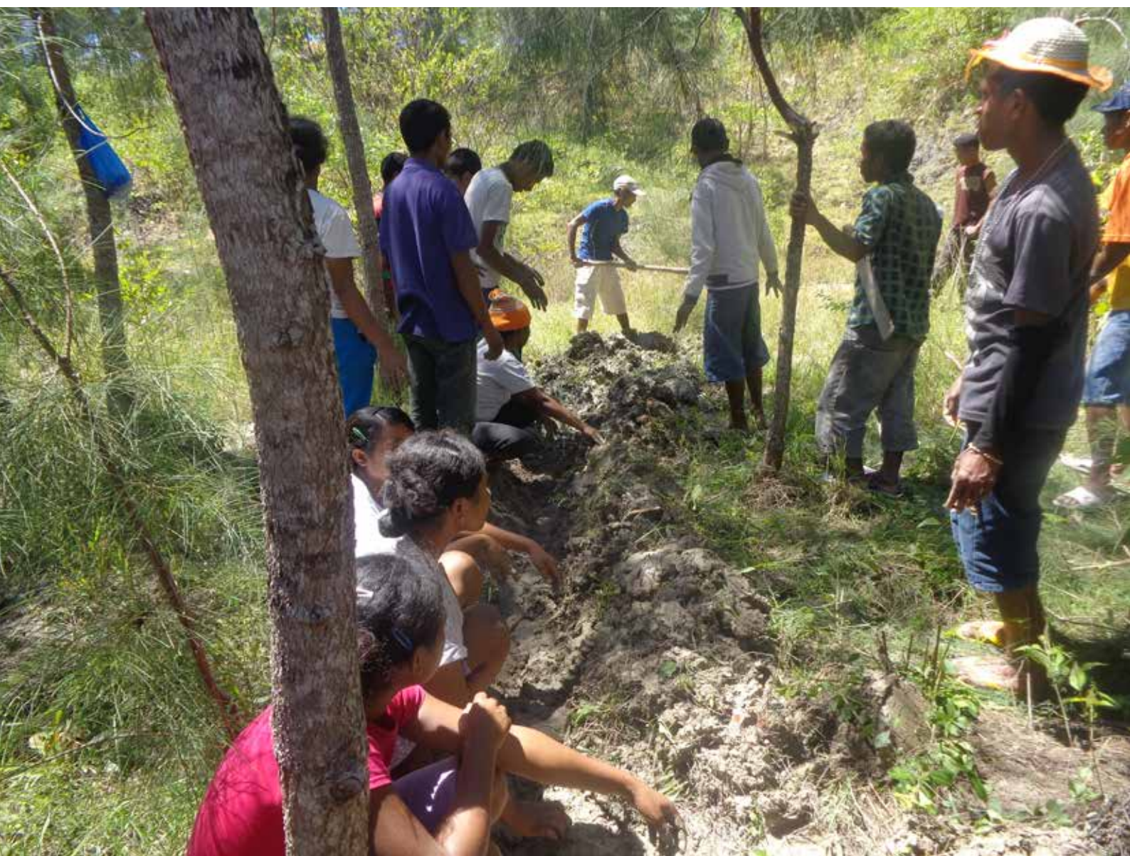
Proses pembuatan saluran air untuk mengurangi genangan yang terletak di Desa Baki.
