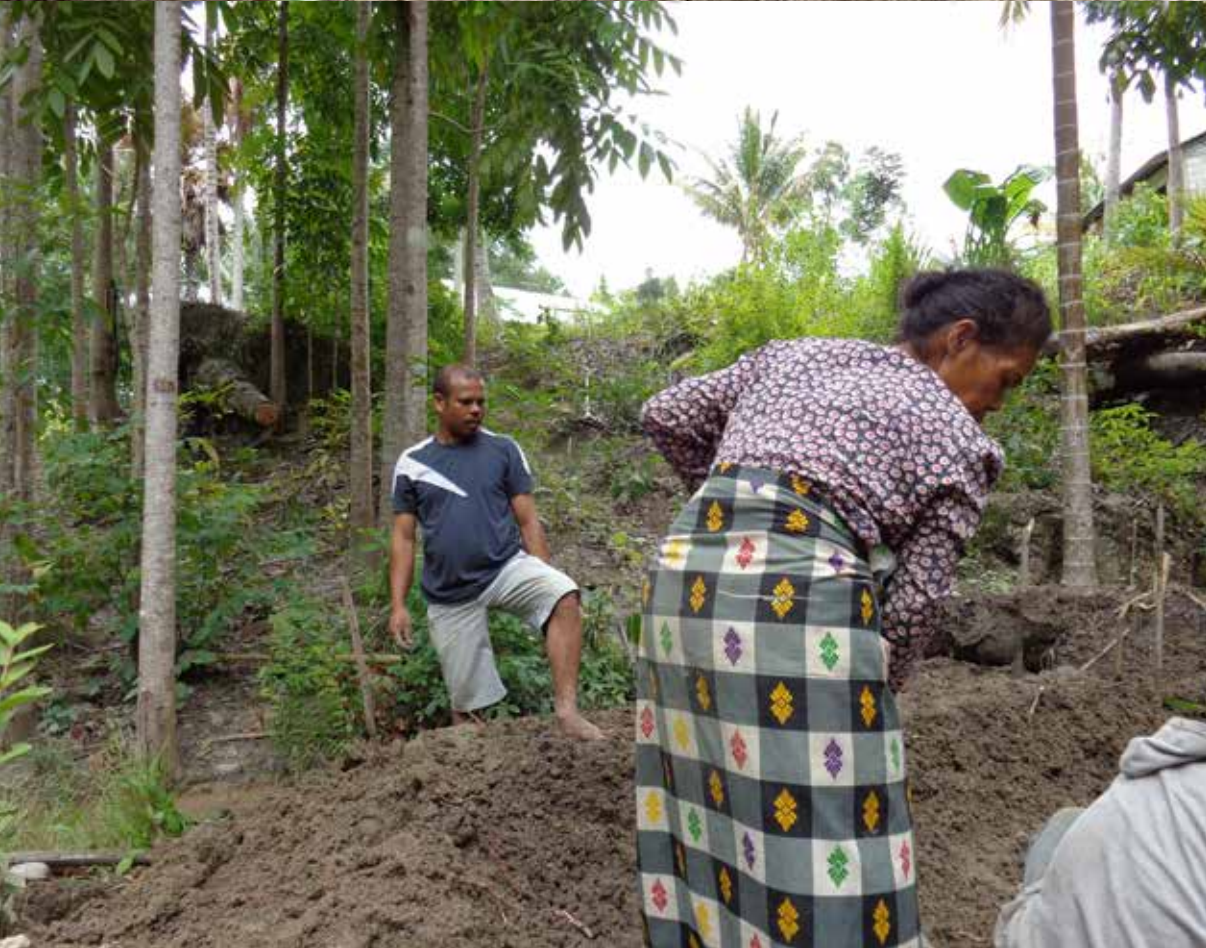
Proses pembuatan teras tanah dan embung tanah di dusun 3.
