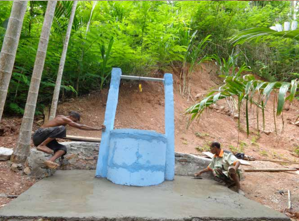
Proses pembuatan sumur di lahan milik salah satu warga.
