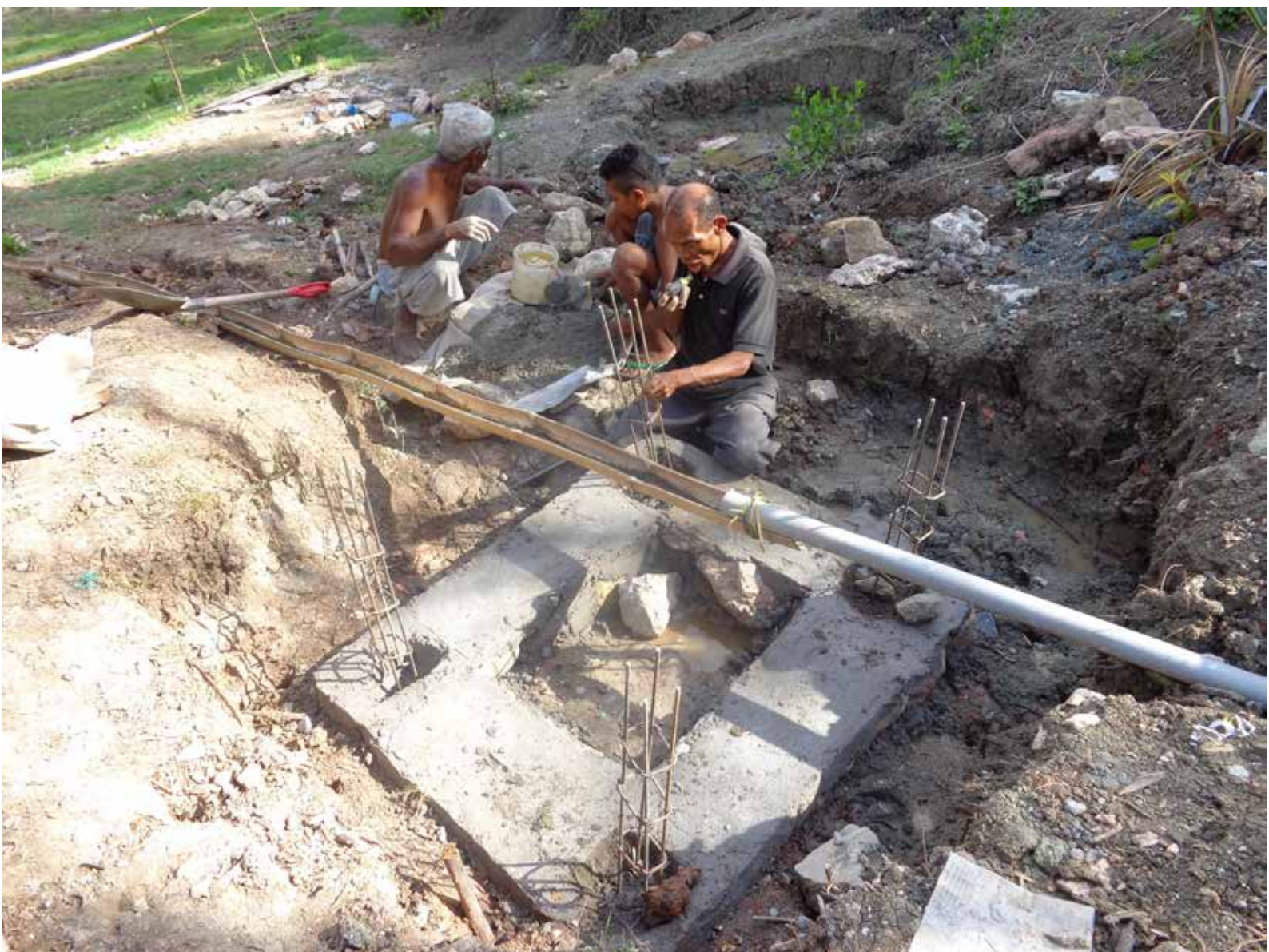
Proses pengerjaan PMA di mata air.
