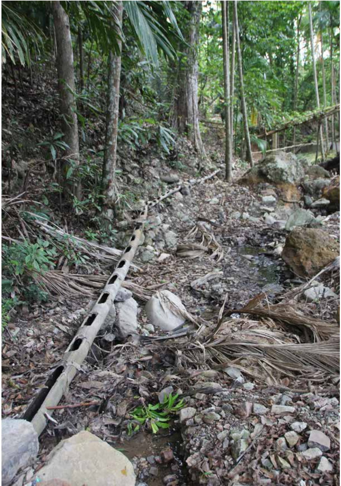
Saluran air sederhana dengan menggunakan bambu.
