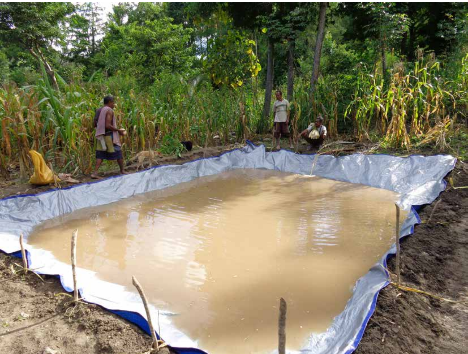
Embung mini dengan menggunakan terpal di dusun 1.
