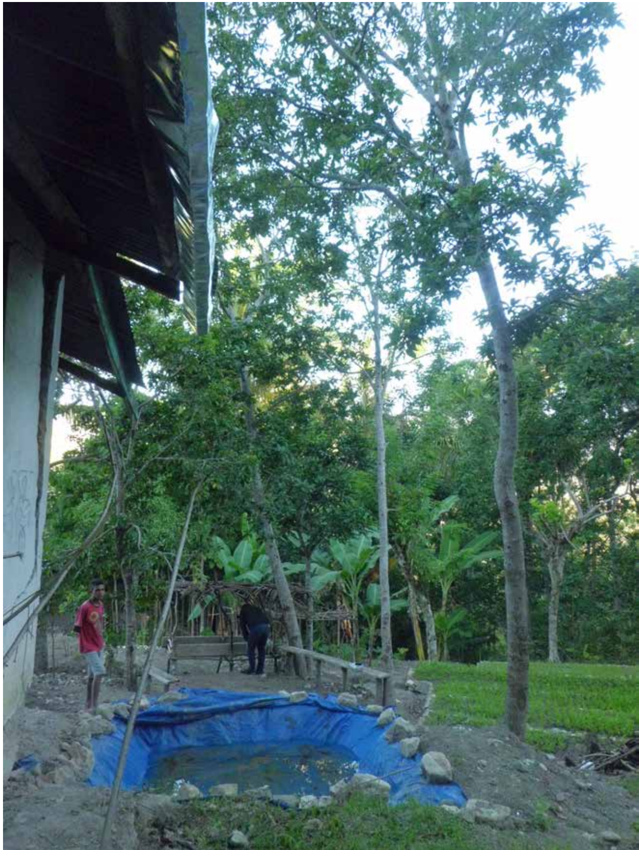
Inisiatif warga - Pengumpulan Air Hujan (PAH) dengan embung beralas terpal plastik sebagai bak penampungan.
