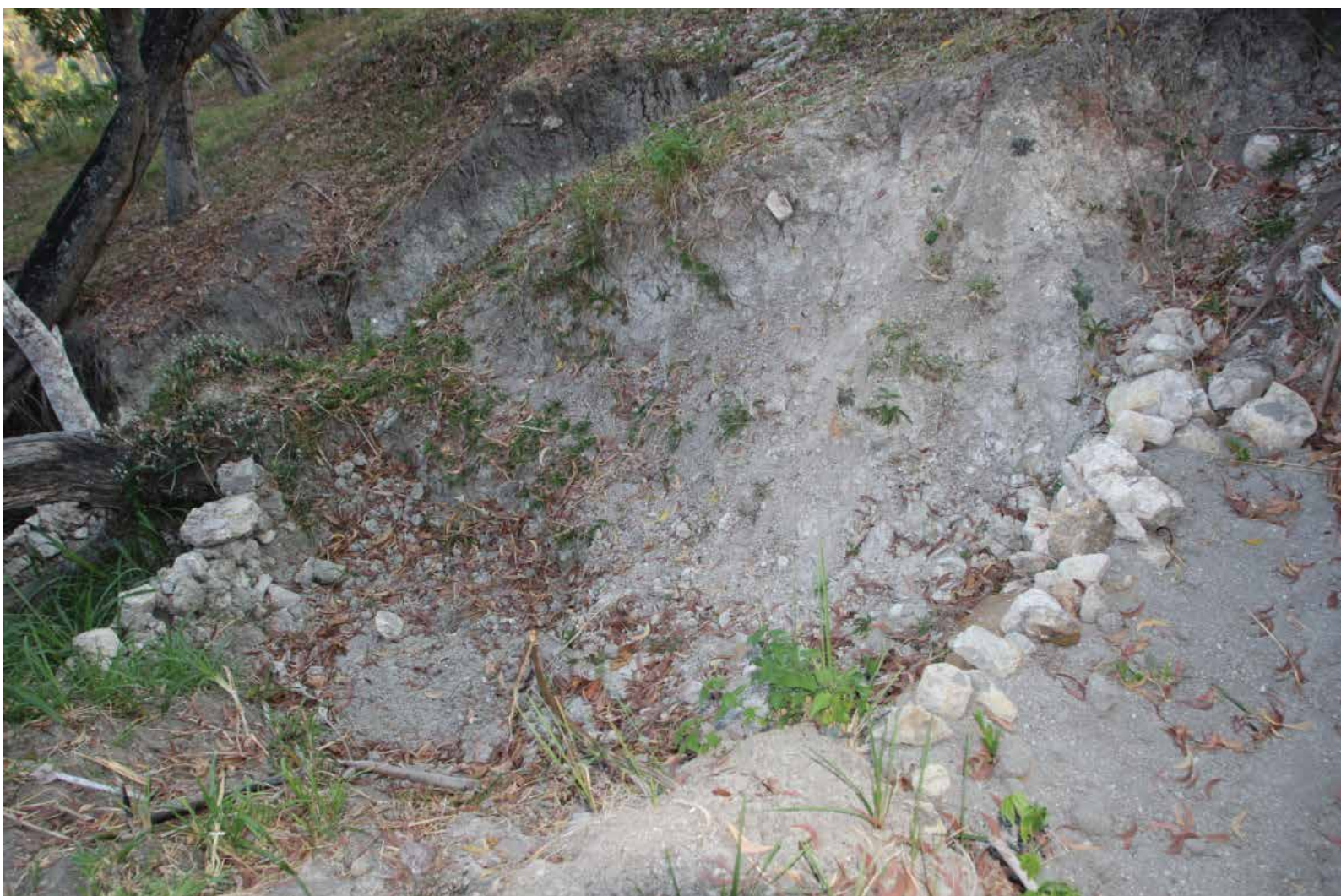
Kondisi jebakan air buatan yang terletak di Dusun 3 Desa Oinlasi.
