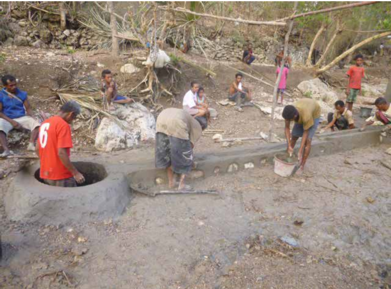
Pembuatan saluran pembuangan air limbah.
