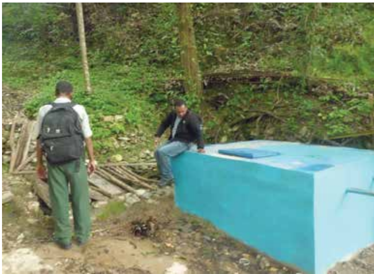
Perlindungan mata air di Desa Nakfunu yang sudah selesai pembangunannya.
