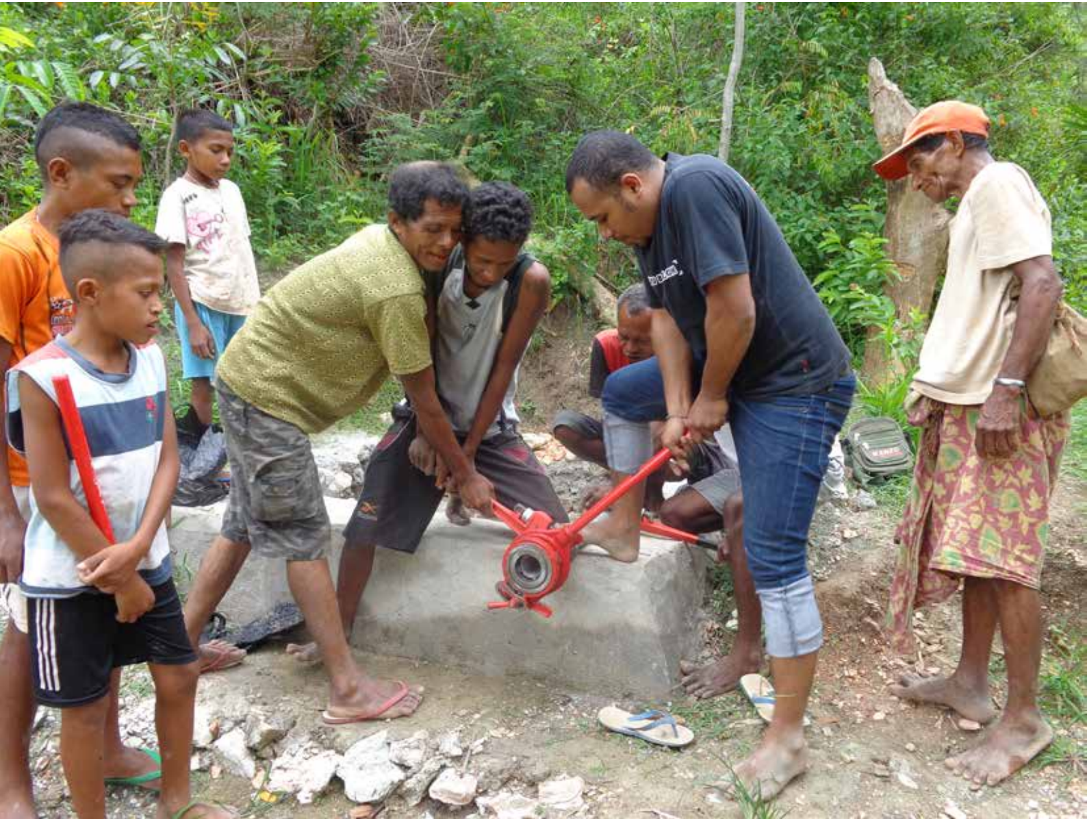
Proses pengerjaan PMA di mata air.
