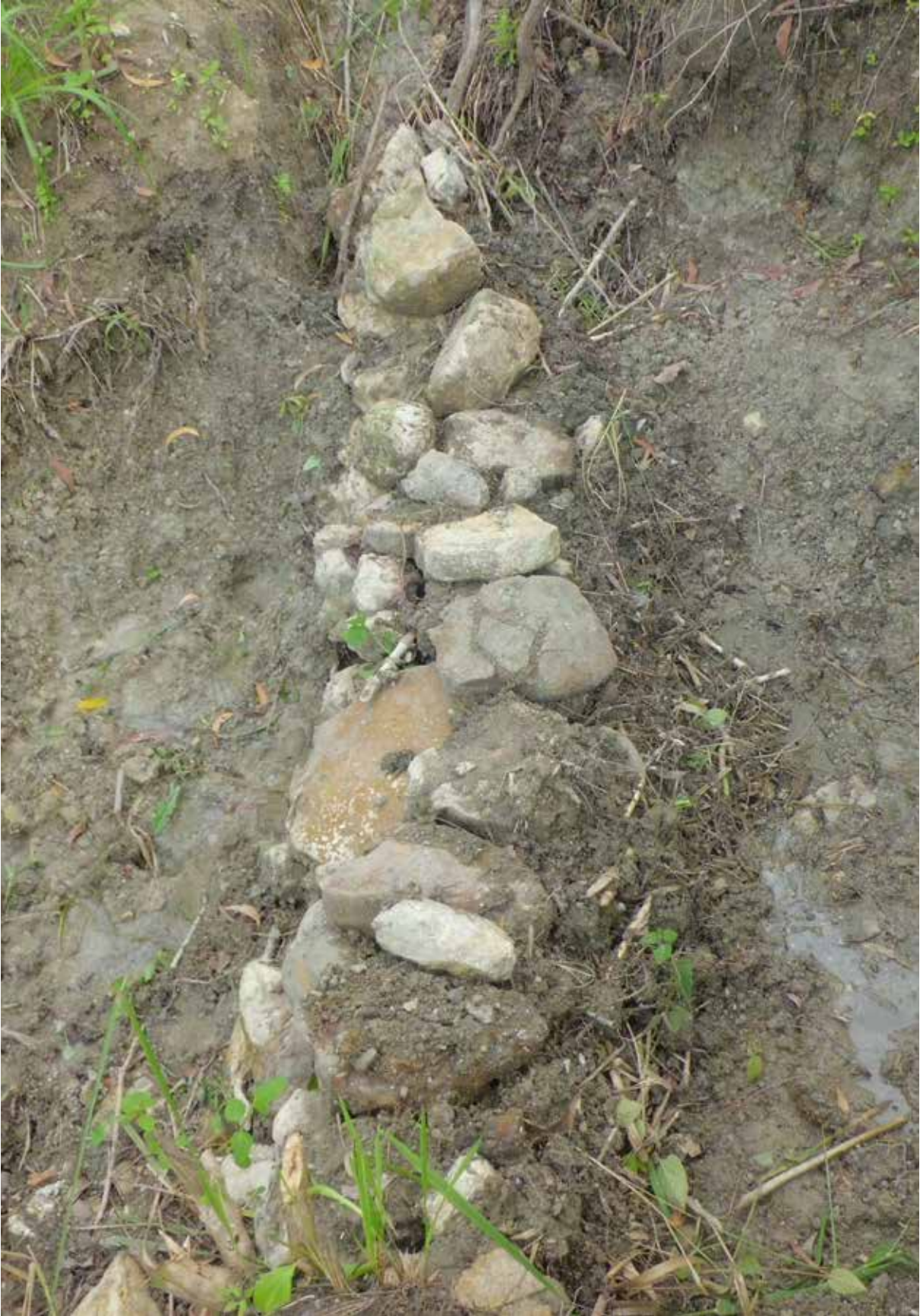
Jebakan air yang baru selesai dan siap difungsikan.
