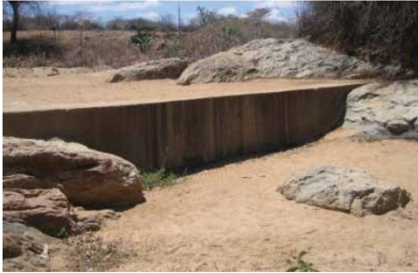
Contoh penyimpanan air: bendungan pasir.
