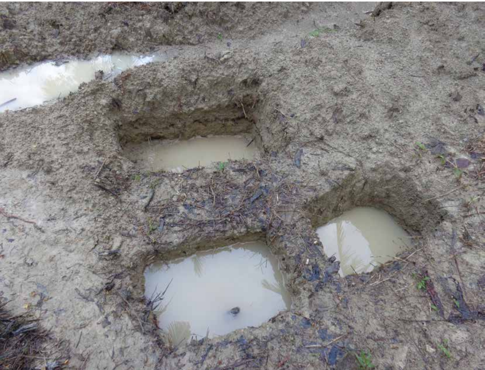
Saluran dan lubang jebakan air yang telah selesai.
