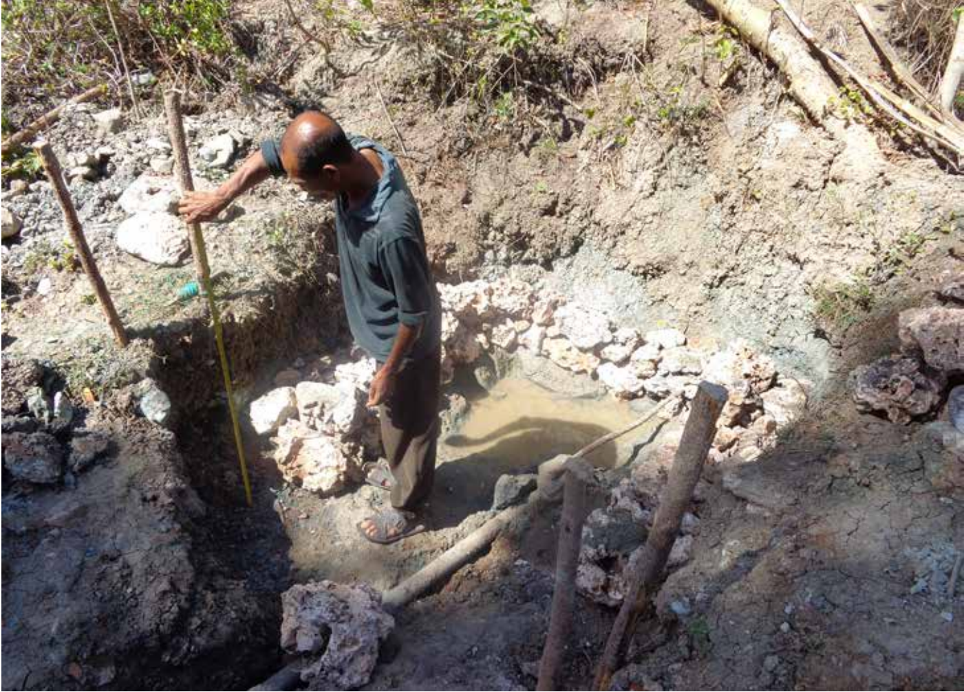
Proses pengerjaan PMA di mata air.
