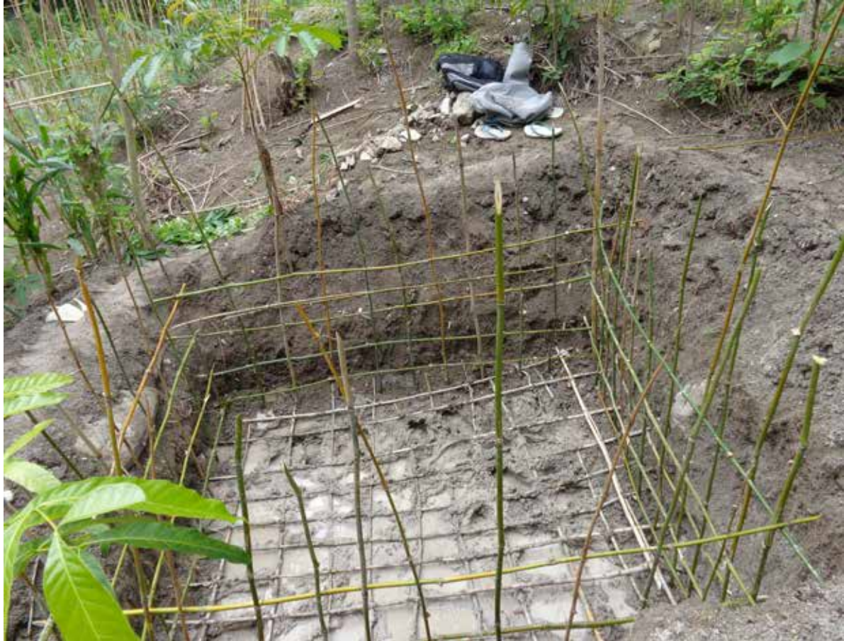
Proses pembuatan embung mini permanen di dusun 2.
